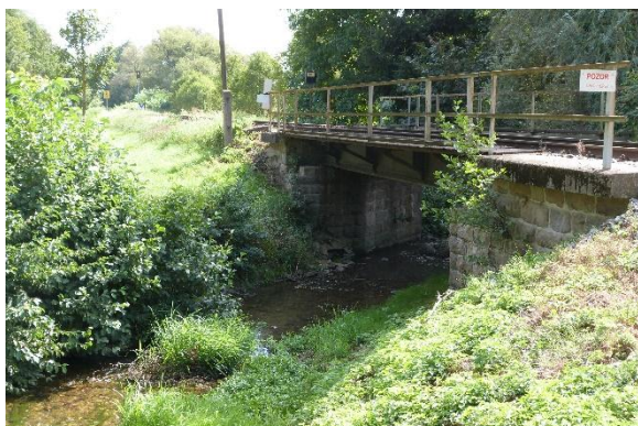
Obr. 25.: Železniční mostek na Besénku
