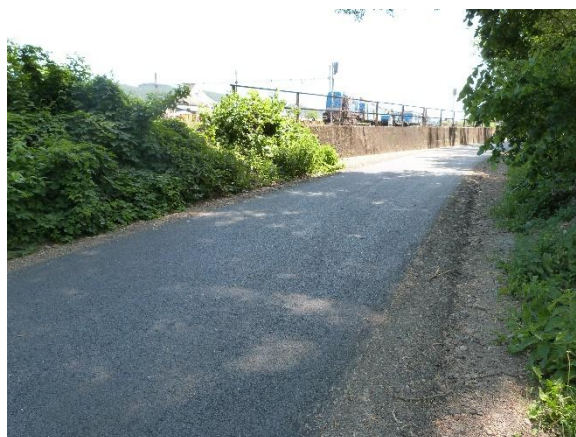
Obr. 16.: Drážní těleso na levém břehu Svatky
