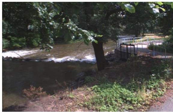
Obr. 12.: Stavidlo náhonu ve Štěpánovicích
