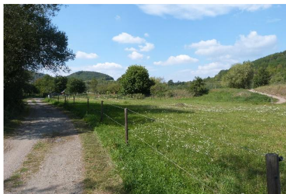
Obr. 22.: Levobřežní odsazená hrázka na Loučce
