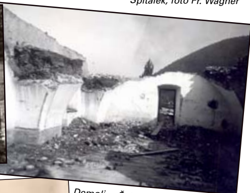
Demolice Špitálku - 40. léta 19. století
