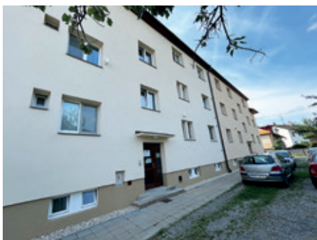
Bytový dům Palackého 1289, 1290, zateplení fasád.
