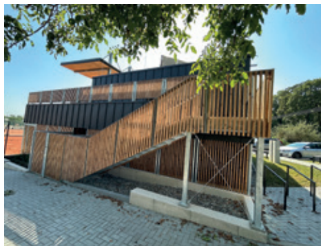
Zázemí pro sportoviště, hlavní vstup.
