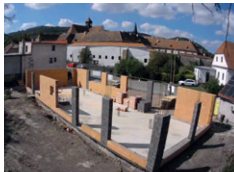
Stav výstavby ke dni 9. 9. 2024.
