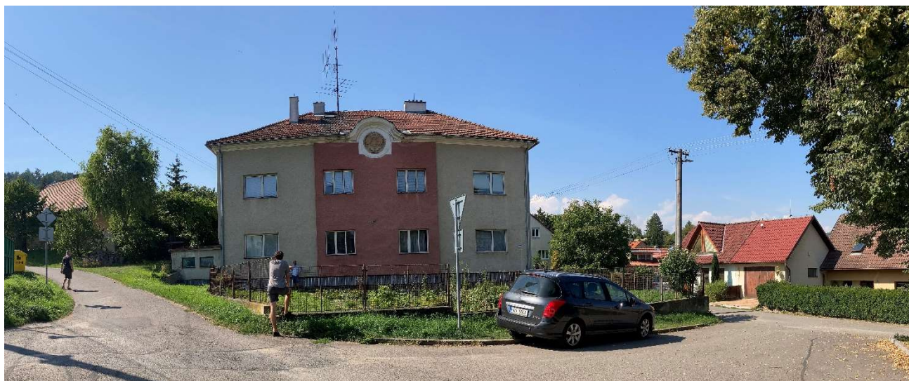
Pohled z ulice Ondřejova na východní fasádu stávající budovy.
